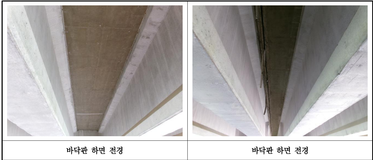
【사진 7.3.27】 바닥판하면 전경
