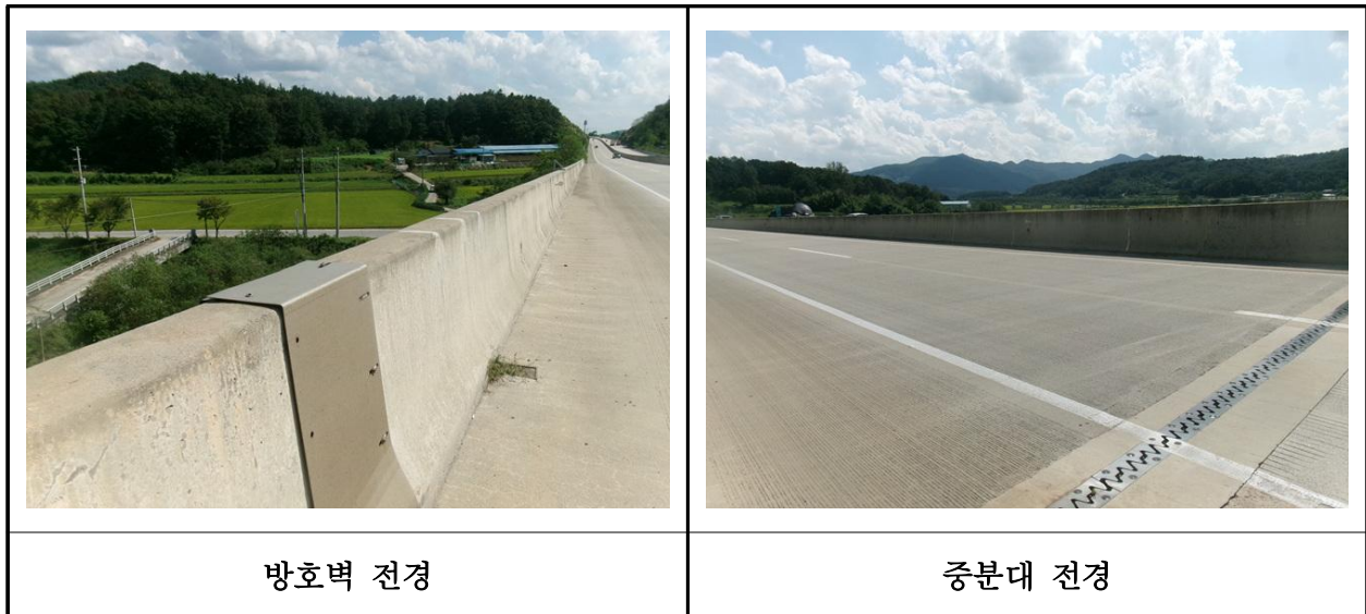
【사진 7.3.23】 방호벽 및 중앙분리대 전경
