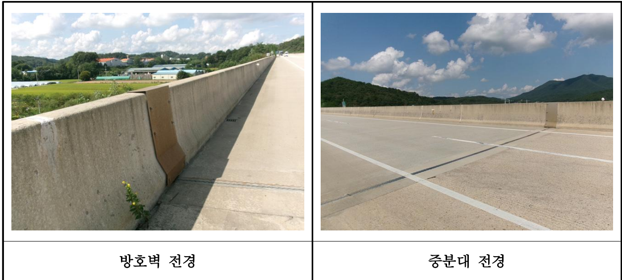
【사진 7.3.48】 방호벽 및 중앙분리대 전경
