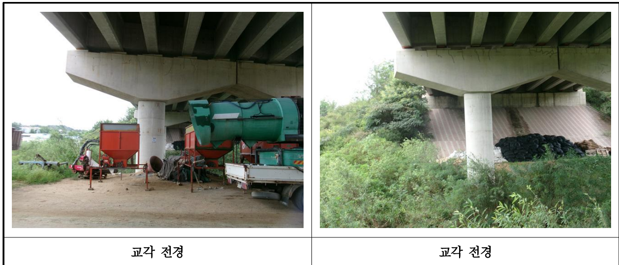
【사진 7.3.35】 교각 전경
