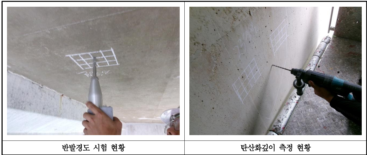
【사진 7.4.1】 콘크리트 내구성조사 현황
