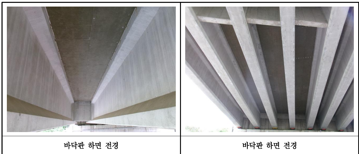
【사진 7.3.2】 바닥판하면 전경
