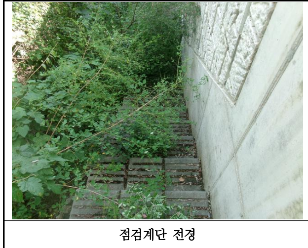
【사진 7.3.25】 교량 점검시설 전경
