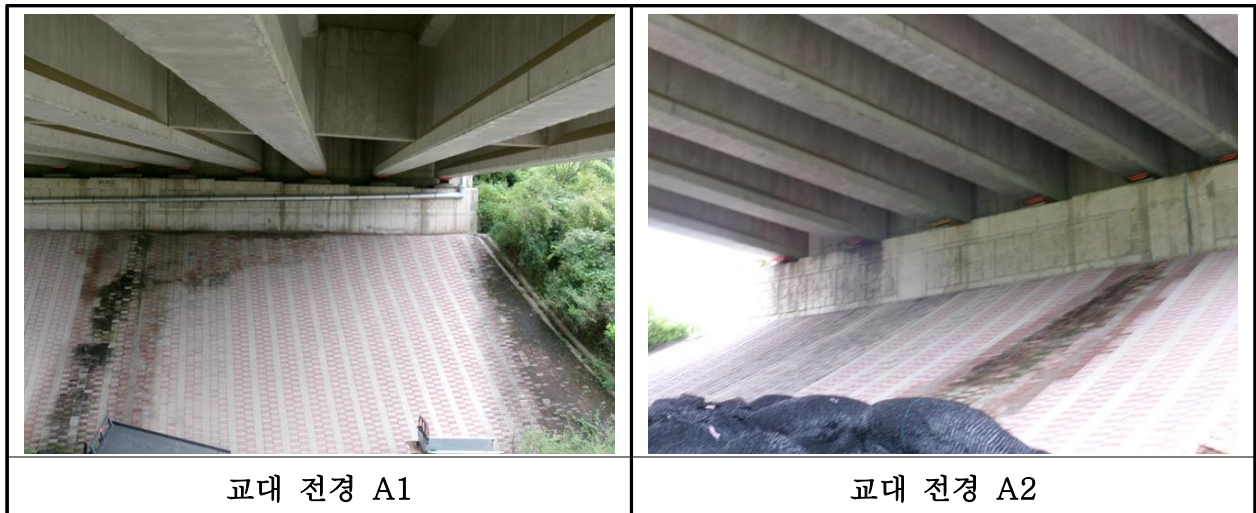
【사진 7.3.33】 교대 전경
