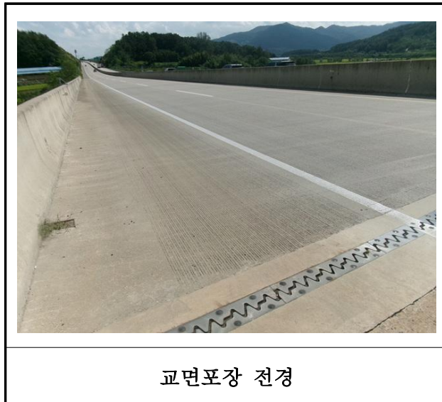
【사진 7.3.19】 교면포장 전경
