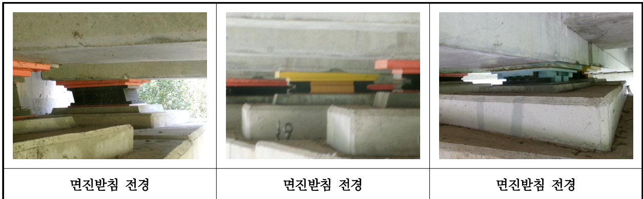
【사진 7.3.12】 교량받침 전경
