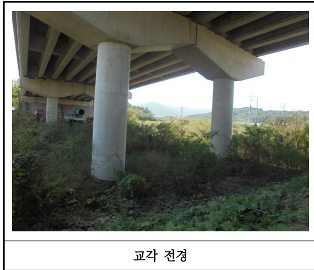
【사진 7.3.10】 교각 전경
