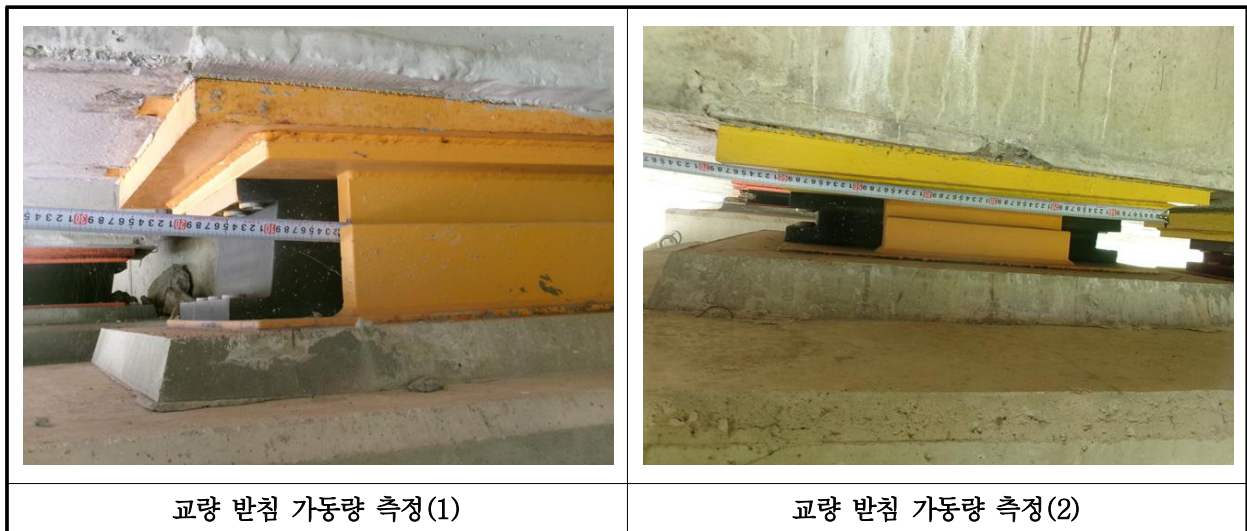
【사진 7.3.40】 교량받침 이동량 측정
