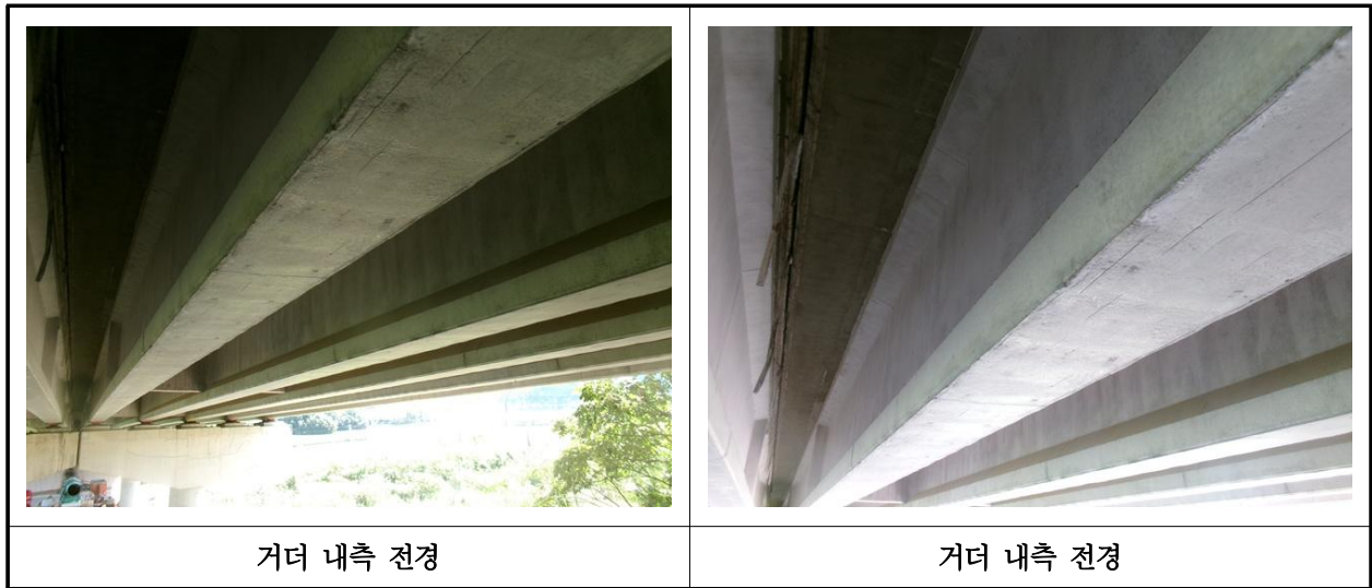
【사진 7.3.29】 거더 전경
