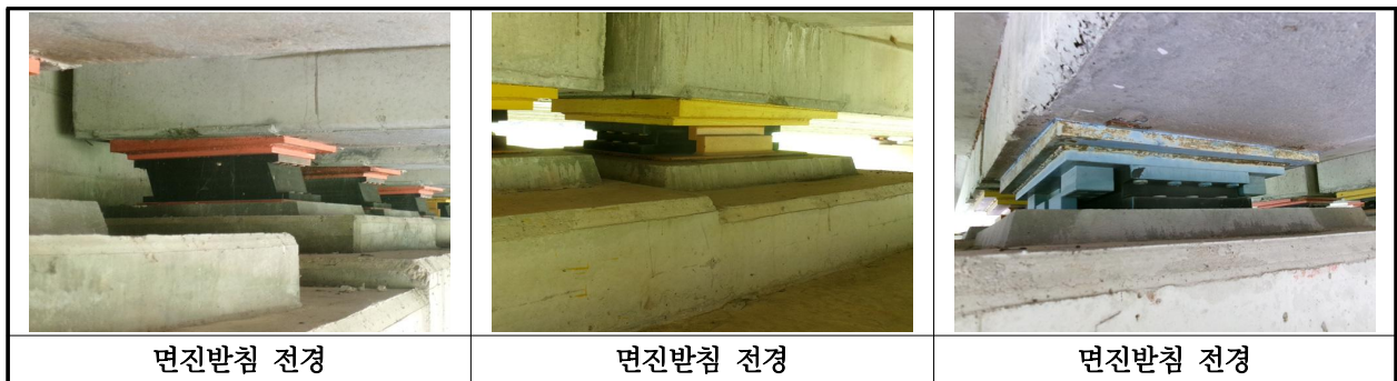
【사진 7.3.37】 교량받침 전경
