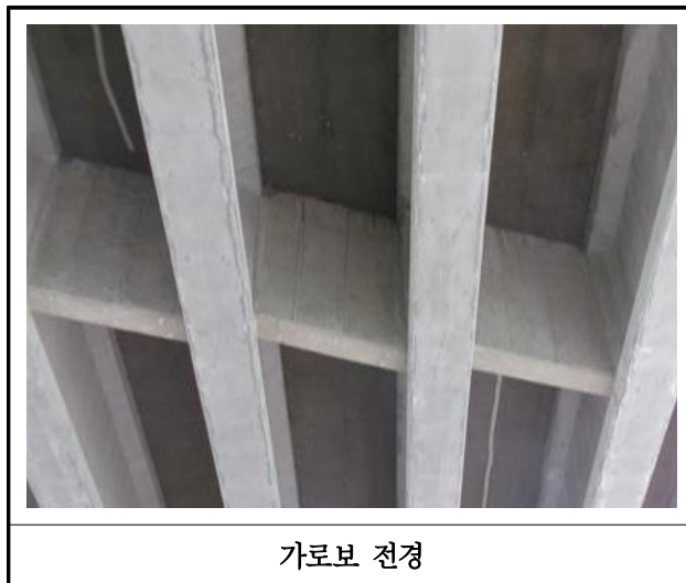
【사진 7.3.31】 가로보 전경
