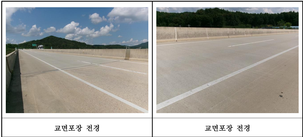
【사진 7.3.44】 교면포장 전경
